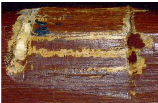
Сліди віджиму на коробі дверей.
